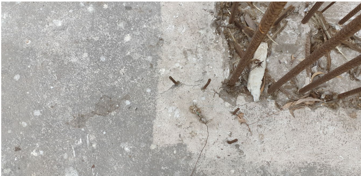
Foto 5.- Presencia de fisuras en la base de la fundación sin sello protector.
