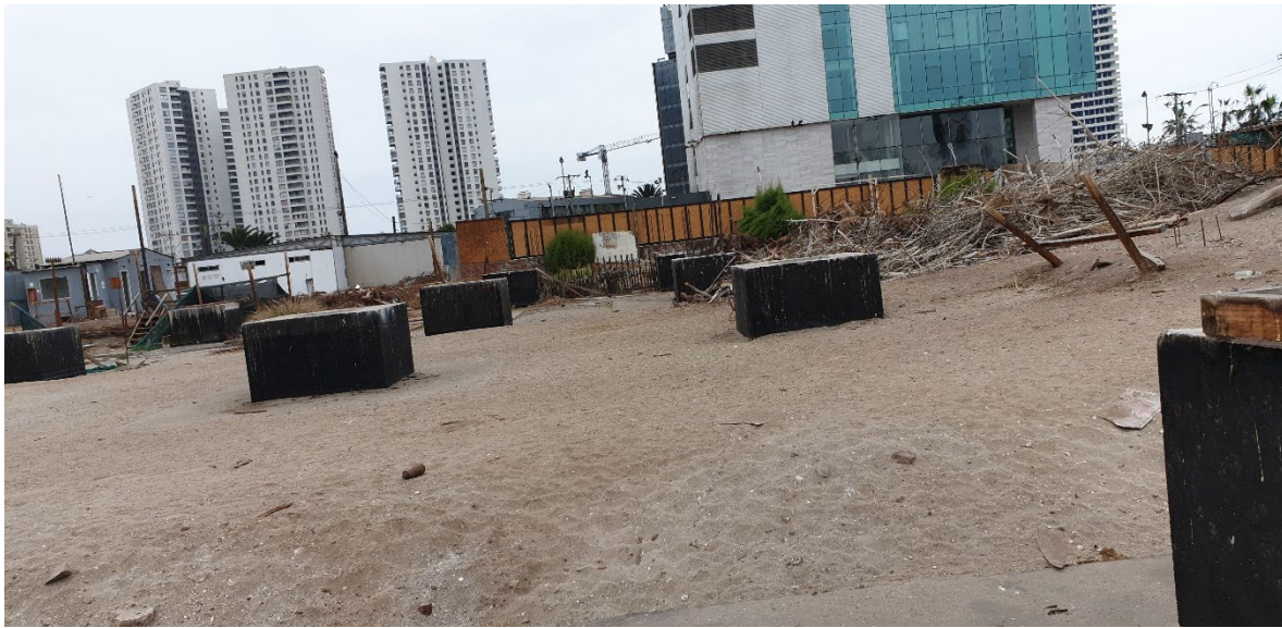
Foto 2.- Vista dados de fundación terminados.
